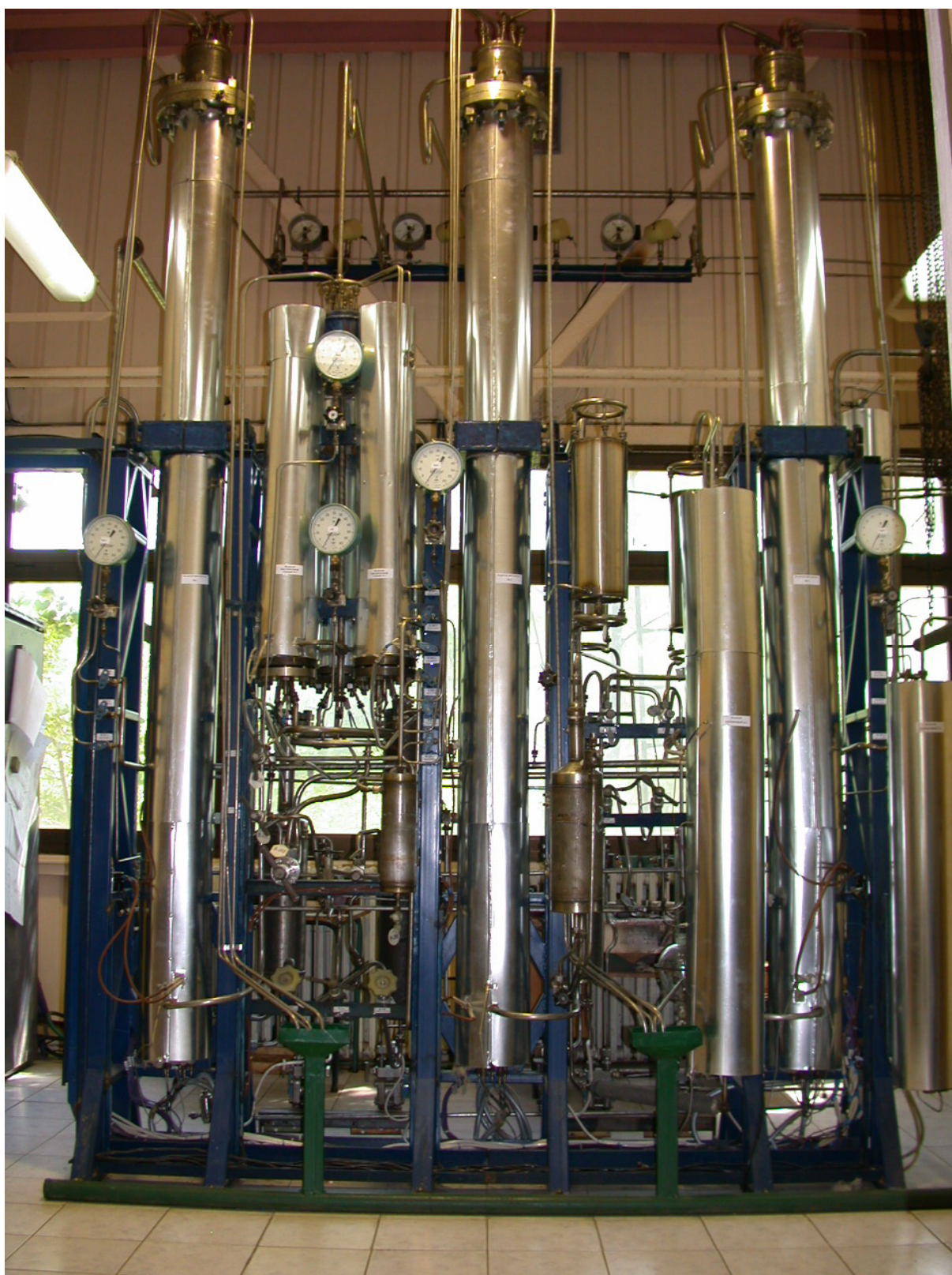
Общий вид установки (химическая часть).
